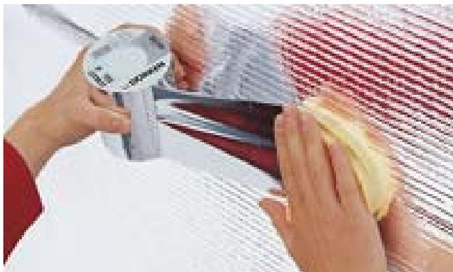
**Description:** ruban collant pour le collage des recouvrements et la réparation de DELTA®-REFLEX
